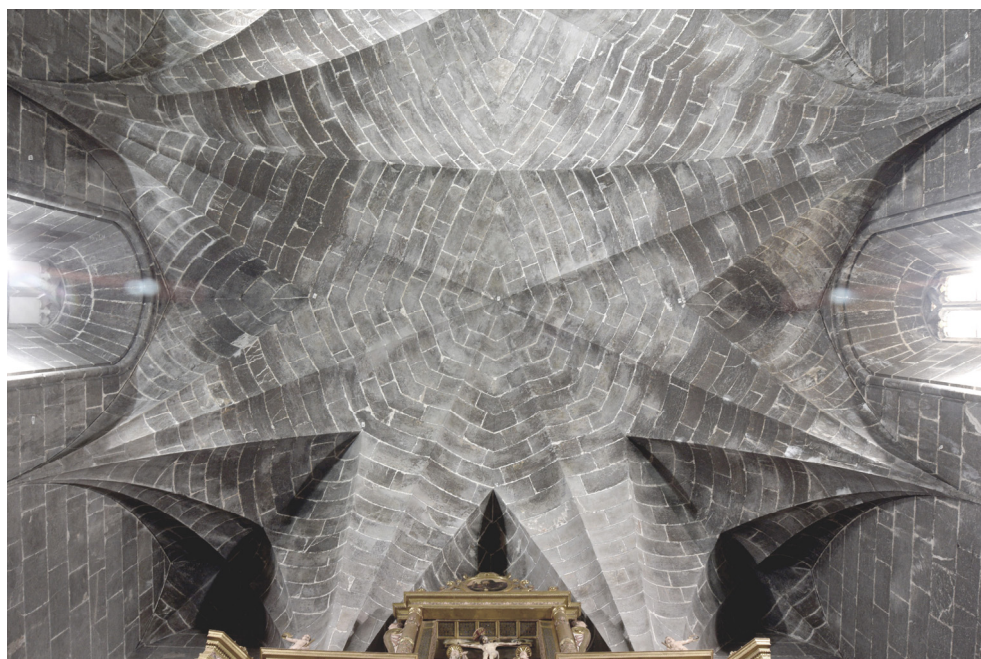
Bóveda aristada en la cabecera de la Capilla Real de Santo Domingo (Valencia).
