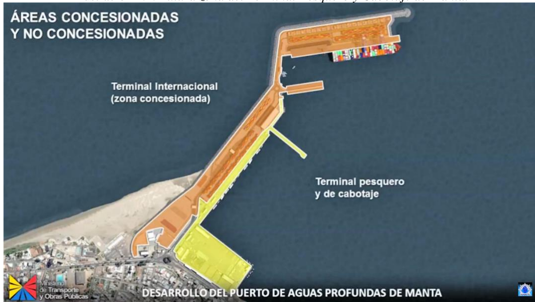
Ilustración 4.2: Futura zona del Terminal Pesquero y Cabotaje de Manta.
