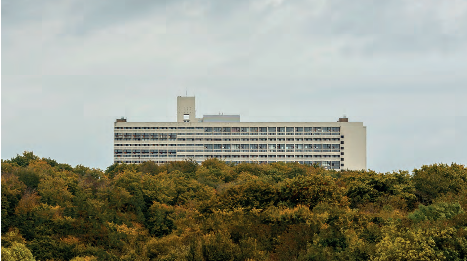
Figura 1. Unité BRF (alzado O). Le Corbusier (1961) / Figure 1. Unité BRF, W façade. Le Corbusier (1961).
