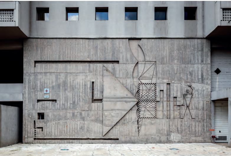
Figura 3. Unité BRF (detalle alzado E). Le Corbusier (1961) / Figure 3. Unité BRF , E façade detail. Le Corbusier (1961).
