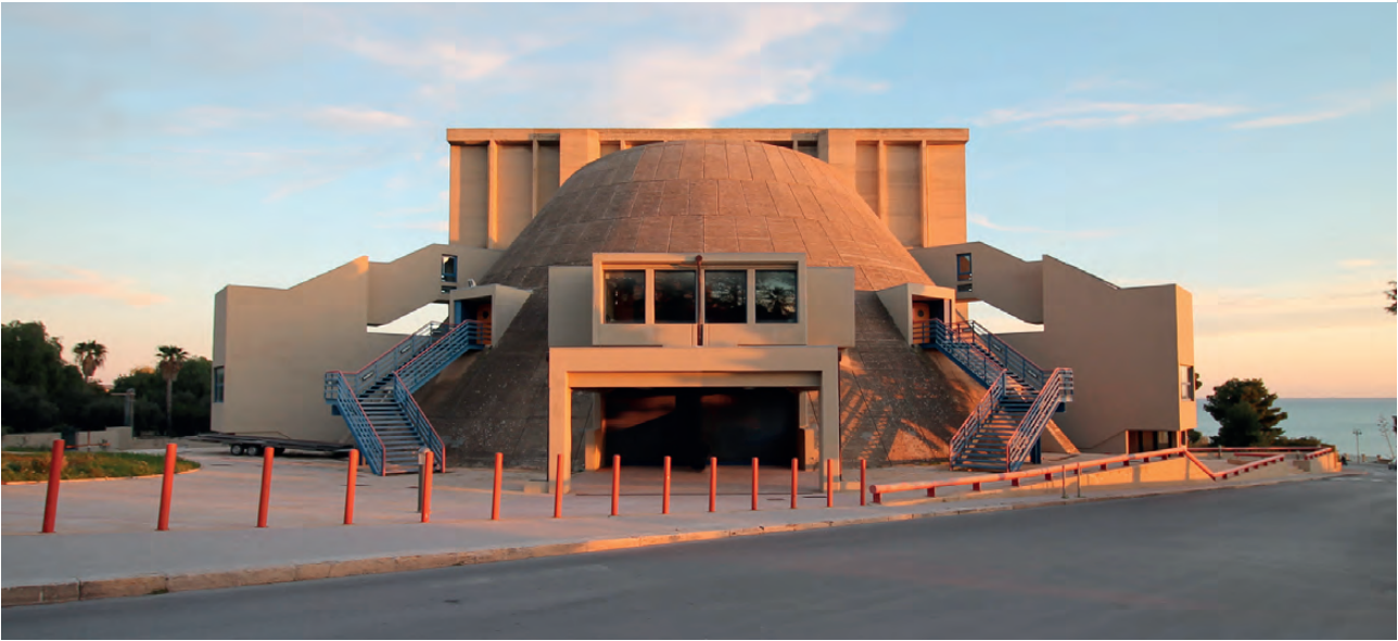
Figura 1. El edificio completo en su estado actual (2017) / Figure 1. The complete building in its current state (2017).
