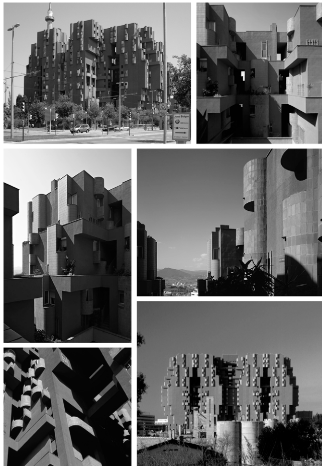
I.40- Vistas del edificio Walden 7. Fuente: Walden 7. Web: http://www.walden7.com/galeria-imatges/
