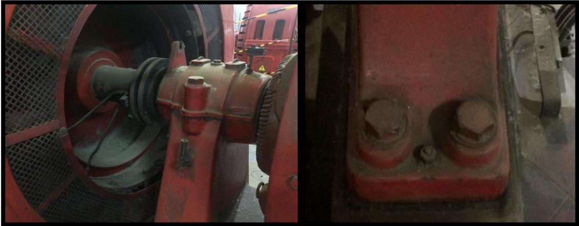
Figura 20 A la izquierda el cojinete de la excitatriz y a la derecha los anclajes del pie de apoyo del alternador.
