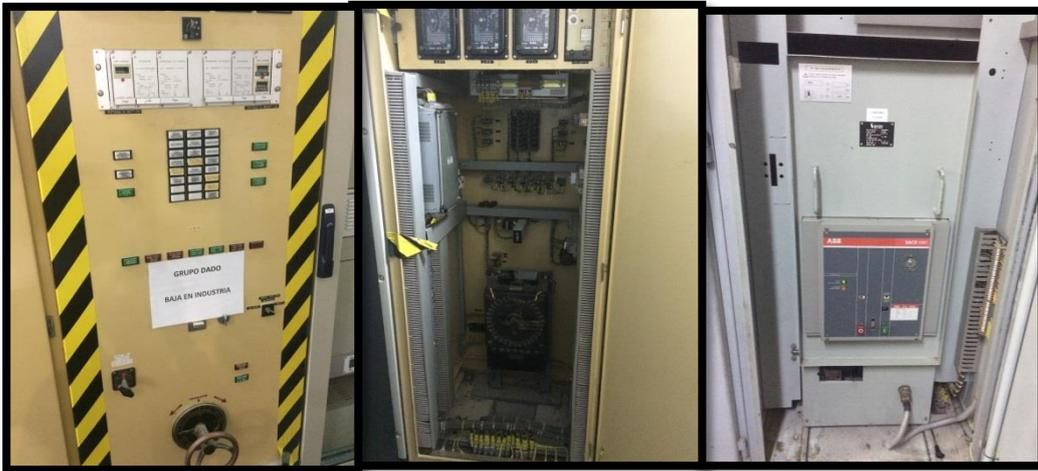
Figura 22 A la izquierda el armario de control cerrado, en el centro este mismo abierto y a la derecha la celda de generación.
