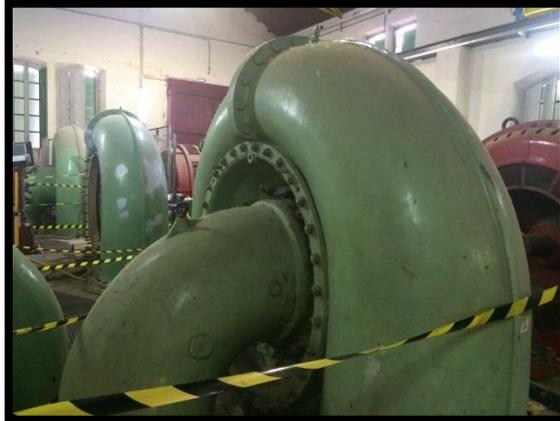
Figura 13 Vista de la cámara espiral junto al codo de aspiración.
