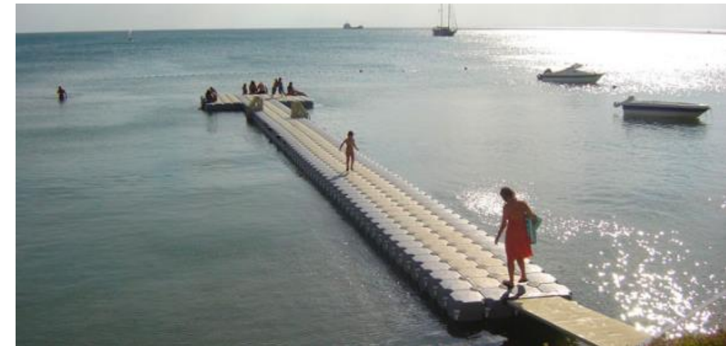
Figura 34.. Ejemplo de pantalán flotante modular (Fuente: http://www.cubidock.com )
