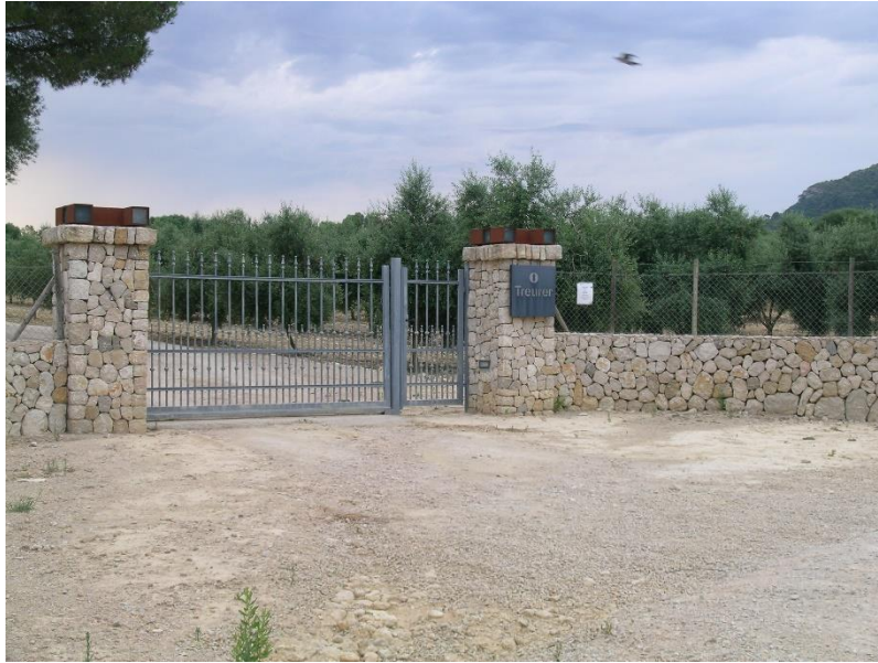
Ilustración 9; Puerta de acceso a la finca Treurer desde Ma-5010
