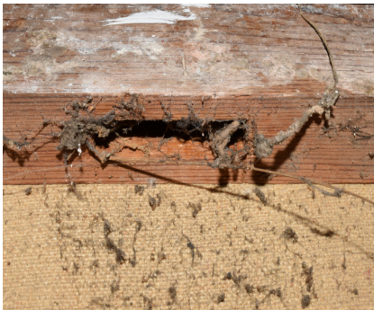
Fig.28: Huecos donde se encontraban los travesaños de la obra.
