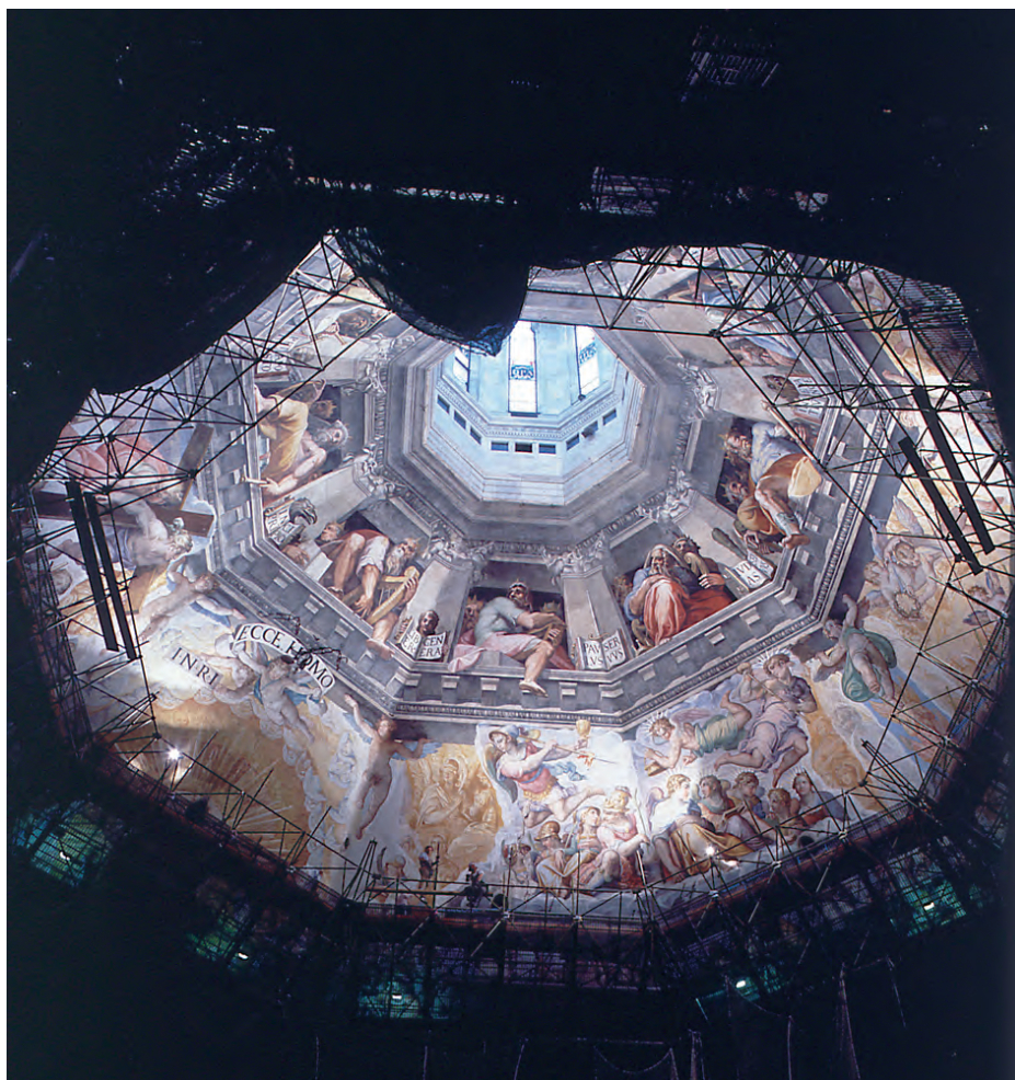
Una visión sugestiva de la linterna y del "tabernacolo dei seniori" durante las primeras fases de desmontaje del andamio
