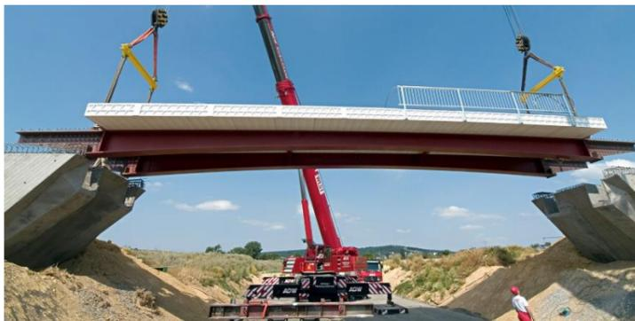
Figura 46 Construcción del puente de Friedberg, Alemania formado por un tablero de materiales compuestos sobre vigas de acero [23]
