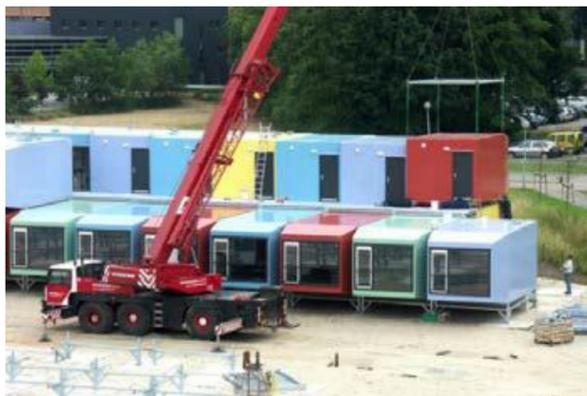
Figura 4 Módulos habitables prefabricados de material compuesto [16]
