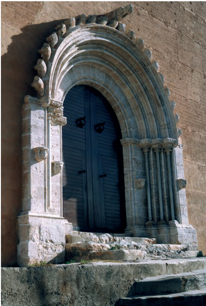
Fachada principal. Puerta gótica del s. XIV restaurada (foto archivo LOGGIA)
