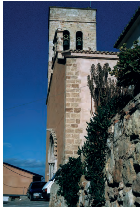
Exterior restaurado (foto archivo LOGGIA)
