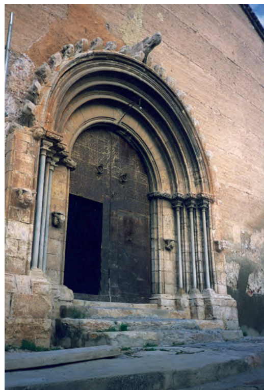
3. Fachada principal. Puerta gótica del s. XIV antes de la restauración
