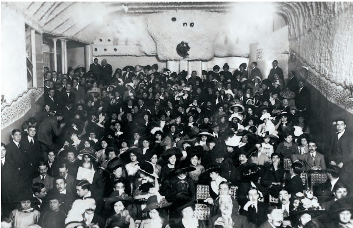
Sala Mercè de Barcelona. Vista general de la sala de proyecciones. (foto: Arxiu GMN)
