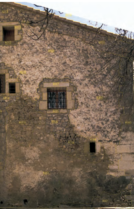
9. Detalle de un estudio de análisis estratigráfico realizado sobre el soporte de una fotografía rectificada con un programa informático. (Santuario de San Juan de la Peñagolosa, Castellón; elaboración propia)
