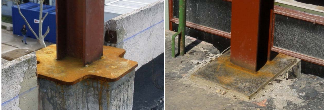
Figura 8. Ejemplos de placas de anclaje contruidos
