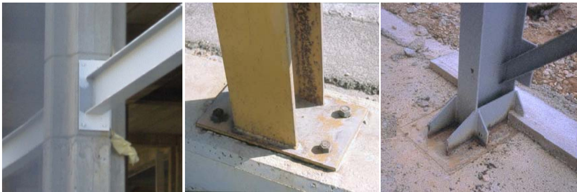
Figura 7. Ejemplos de placas de anclaje construidos
