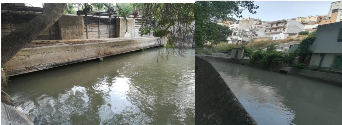
Imagen 2. Canal de la central hidroeléctrica donde se localizan los sumideros.
