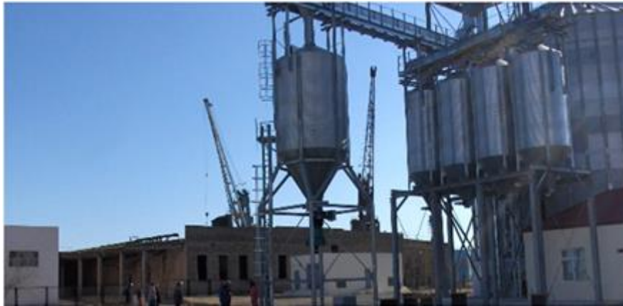
Ilustración 10: Silos de carga a granel
