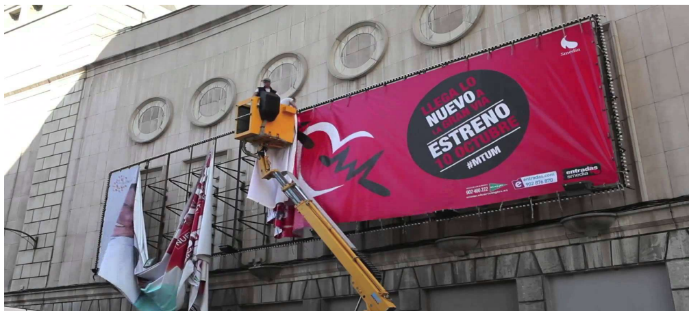
FIGURA 3.2: Ejemplo del montaje de una lona impresa.
