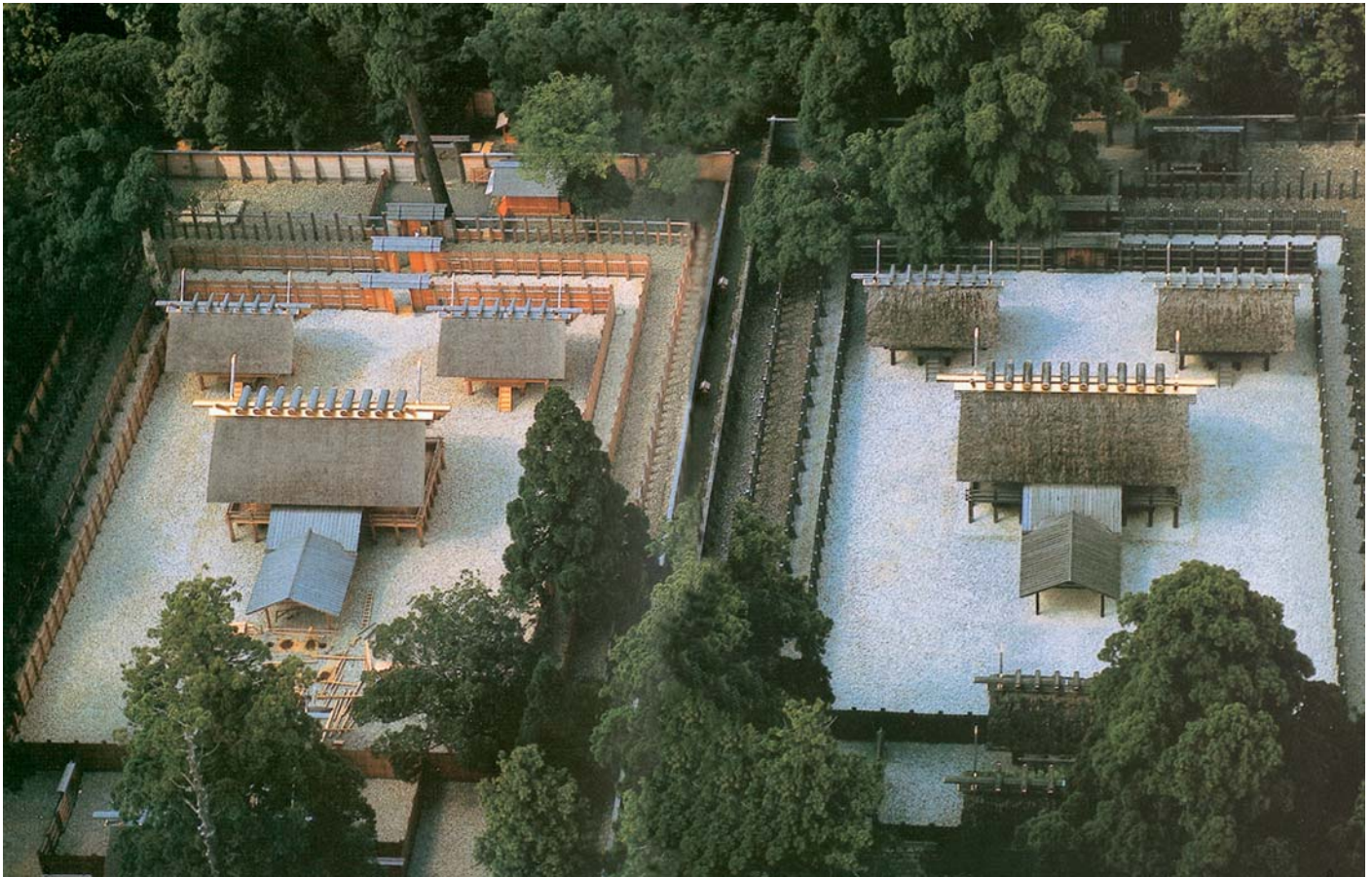
30. Curiosa vista aérea del Santuario de Naiku durante el mes en que conviven los dos edificios, antiguo y nuevo, original y copia, antes de destruir el primero de ellos (foto: Mainichi Shinbun)
