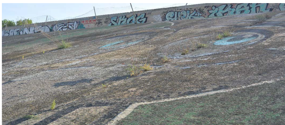
Figura 25: Detalle del crecimiento de plantas y el desarrollo de musgos en la superficie mural.
