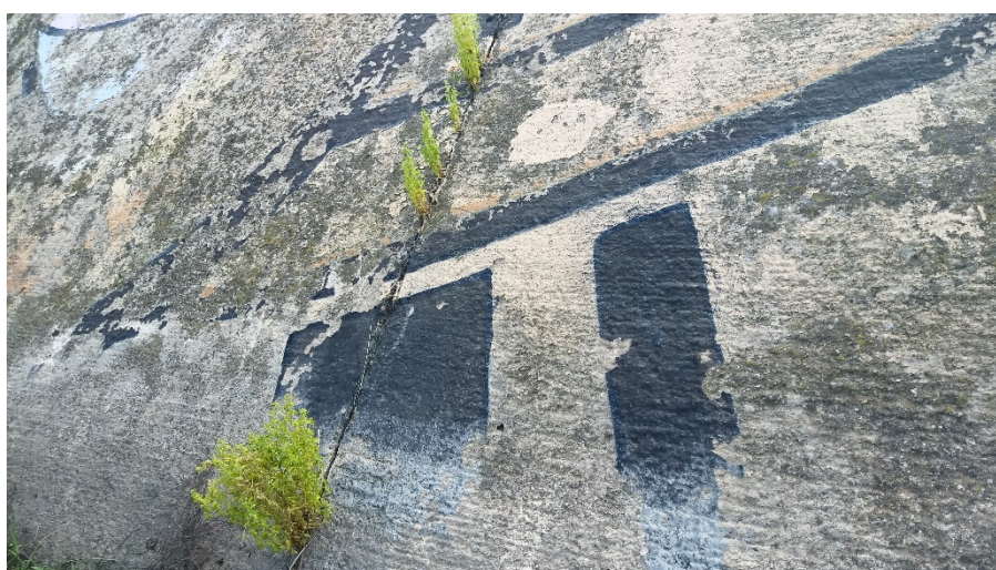
Figura 26: Detalle de incrustaciones salinas en forma de costras blanquecinas.
