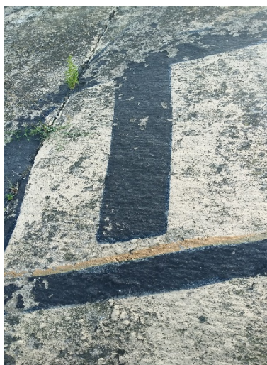
Figura 21: Detalle del estado en el que se encuentra el color negro en algunas zonas.
