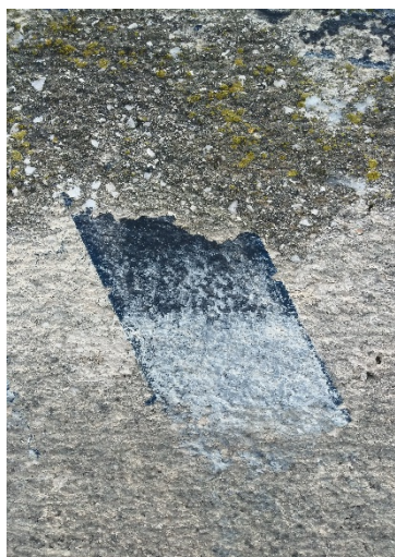
Figura 26: Detalle de incrustaciones salinas en forma de costras blanquecinas.
