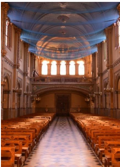
Figura 14: Vista del coro
