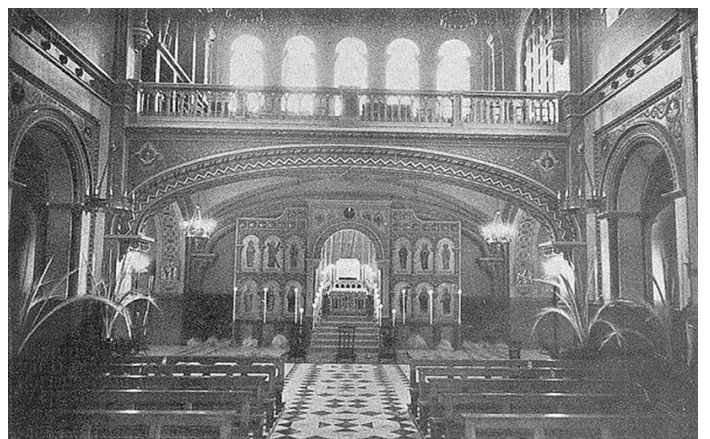
Figura 10: Foto interior de la zona del coro tras la última reforma en 1941
