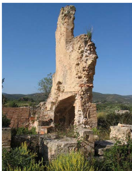
Fig. 9: Celda del Hermano Cocinero.
