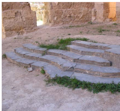
Fig. 14: Gradadas del altar de la Iglesia Mayor. En las paredes se observan las marcas dejadas por el mortero de los azulejos.
