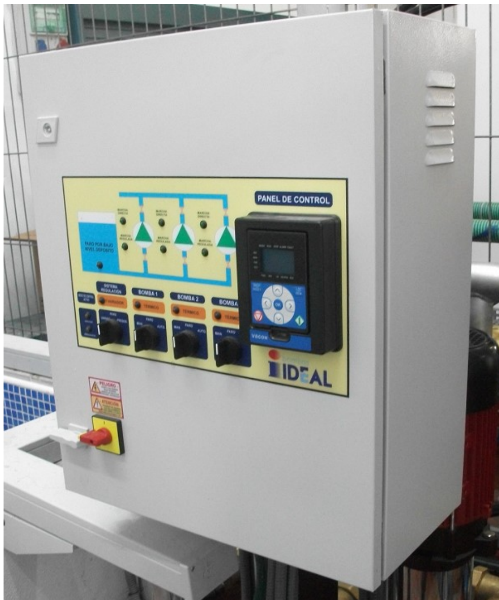
Figura 53. Variador de frecuencia de las bombas.
