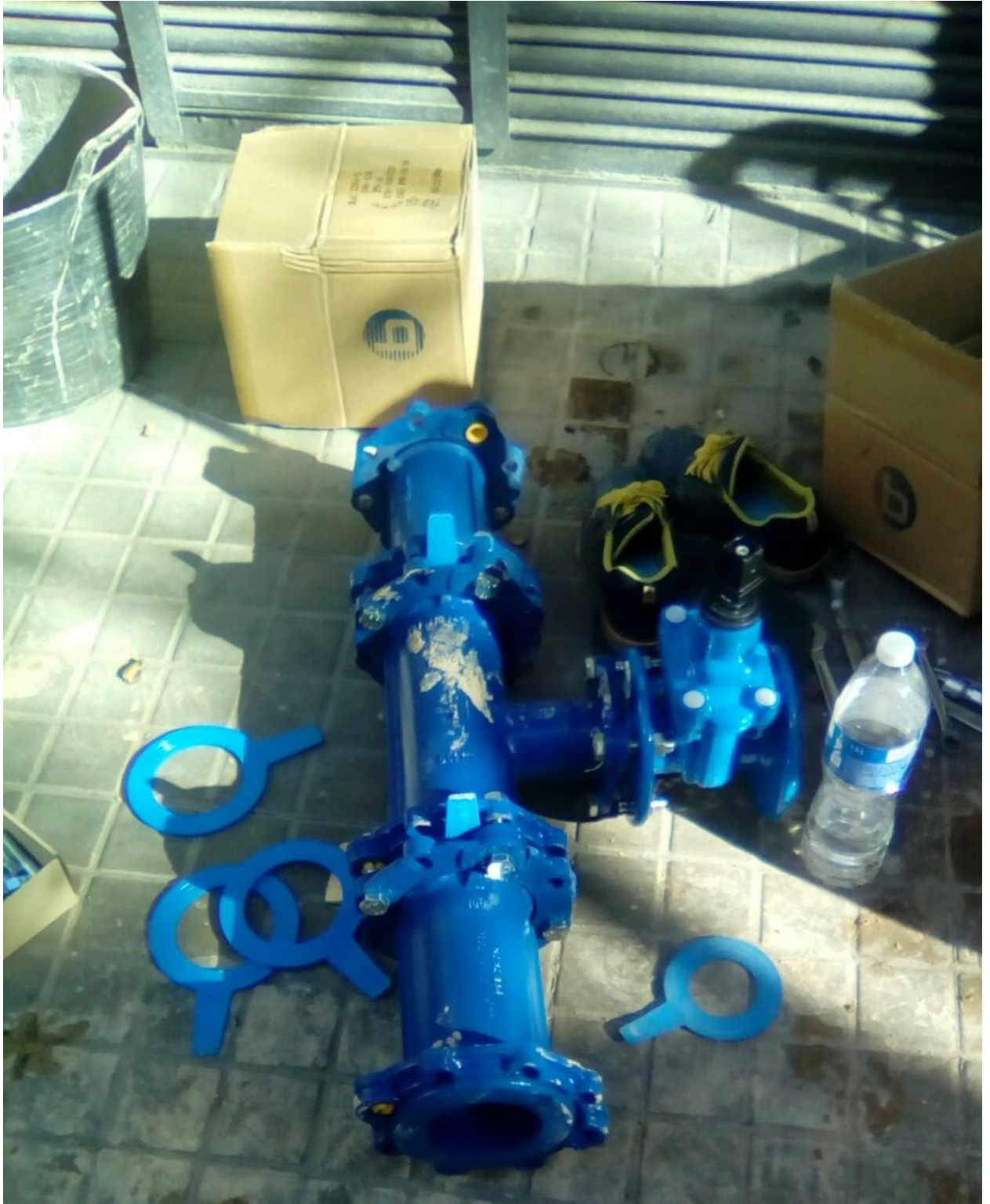
En esta obra se vio el proceso de colocar la T nueva, y el corte del tubo antiguo para hacer el empalme y el añadido de los extremos.
