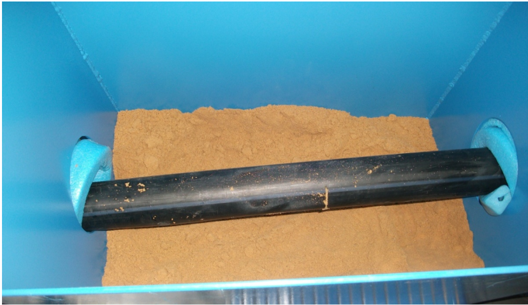
Figura 79. Enterramiento del tubo, mitad del proceso.
