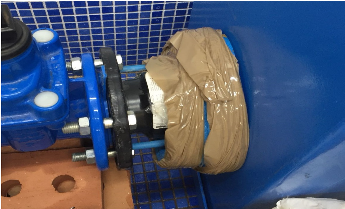
Figura 81. Tapón lateral para contener el agua.
