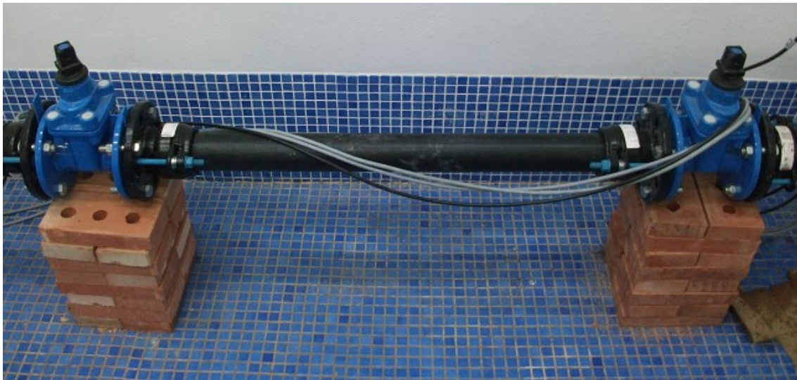
Figura 36. Tubería instalada para su ensayo, y sus válvulas de corte antes y después de la misma.
