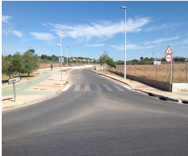
Figura 25. Imagen de la calle 130 por donde baja el colector D 1400 mm que recoge gran parte de las aguas pluviales y las comunica con el colector de la Defensa. Fuente: Trabajo de Fin de Grado (TFG) de Juan José Verdú Macián
