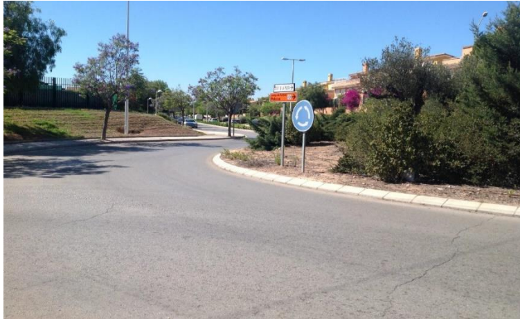
Figura 22. Imagen de la rotonda al norte del barrio los Virgen de los Dolores (al lado oeste de las vías) por donde tuerce hacia la izquierda un colector que conecta con el colector D800 mm que comunica Masies con San Isidro y vierte sus aguas al barranco del Carraixet. Fuente: Trabajo de Fin de Grado (TFG) de Juan José Verdú Macián
