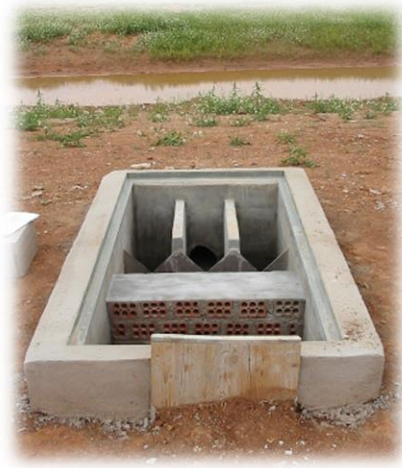
Figura 55. Arqueta de repartición durante su construcción. Fuente: Depuración con humedales construidos (García y Corzo, 2008)
