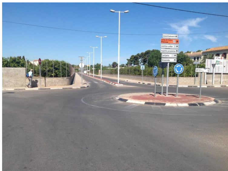
Figura 26. Imagen de la rotonda donde se ubica el cajero (con su respectivo aliviadero) donde se comunican el colector de la Defensa que viene de Norte a Sur en esta imagen y el colector D 700 mm del Este de la imagen. Fuente: Trabajo de Fin de Grado (TFG) de Juan José Verdú Macián
