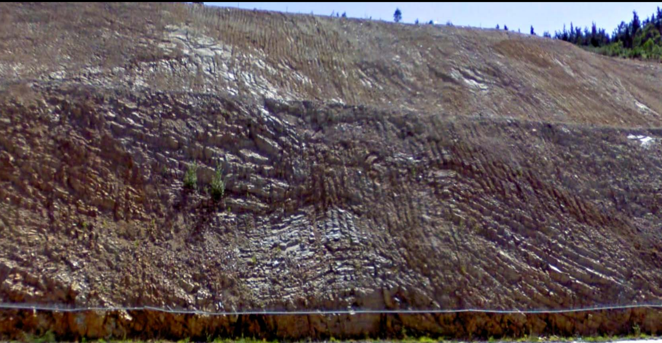
Pliegues y fallas en un talud de Autovía del Cantábrico, en las pizarras y cuarcitas del Cámbrico del NE de La Magdalena, Centro S Hoja de Ribadeo.
