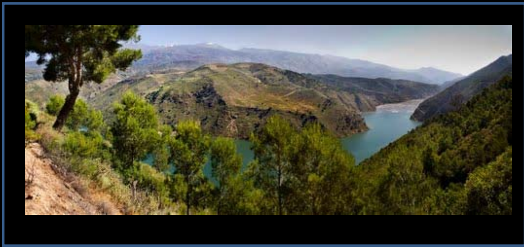
Presa de Rules y cola del embalse hacia Orgiva (errece/joces-awindx-google) NE de Vélez de Benaudalla, en el Río Guadalfeo, SW Hoja de Lanjarón.
