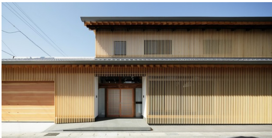
Fig. A. 01. Restauración casa tradicional. Fachada. Shigeru Aoki.
