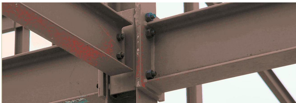
Figura 24- Uniones atornilladas.
