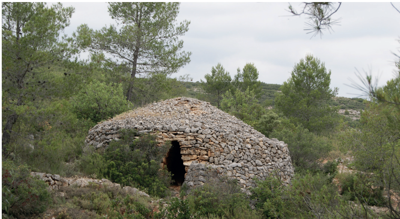
Fig. 52. Vista del cuco Manuel Abad. Enguera.
