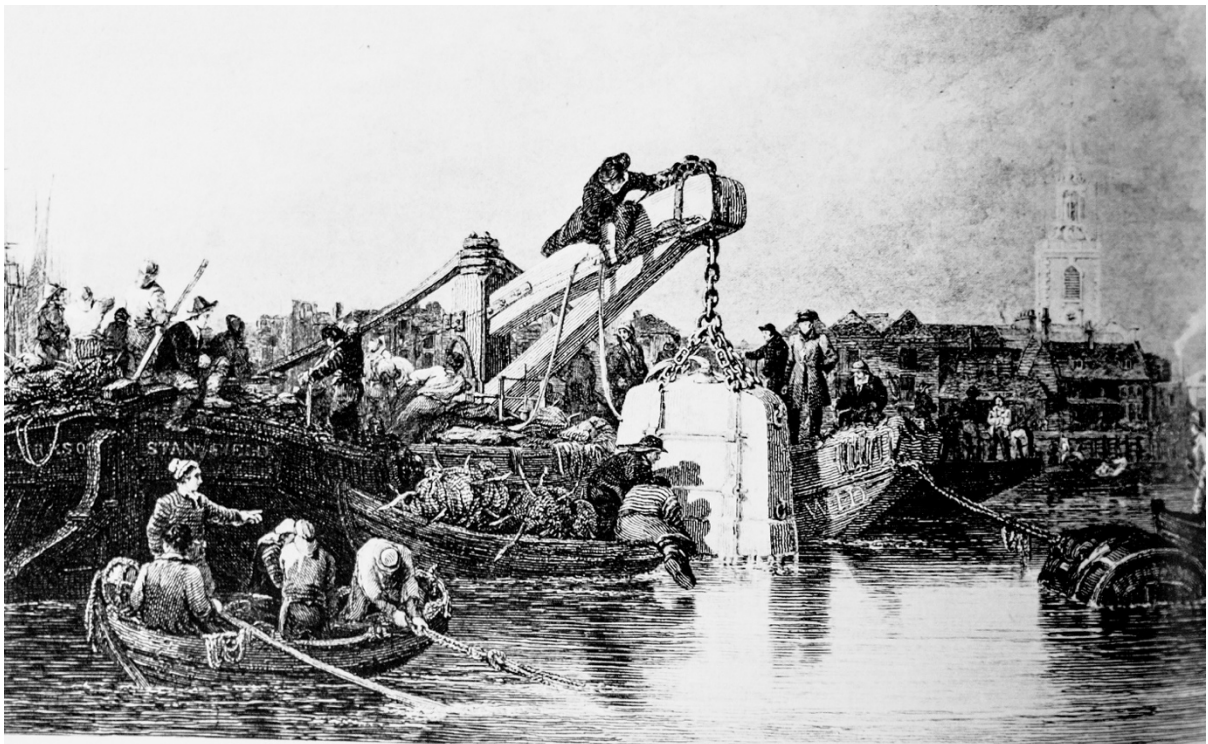
131 En la primavera de 1827, Humboldt pasó casi una hora en el fondo del Támesis en la campana de buceo usada por Brunel durante la construcción del túnel del río. Le recordó vivamente su ascensión al Chimborazo: se le reventaron vasos sanguíneos del pecho, escupía sangre y la nariz le continuó sangrando hasta el día siguiente. Grabado de G. Cook, a partir de un dibujo de Clarkson Stanfiel, 1827. Southwark Libraries, Londres.
