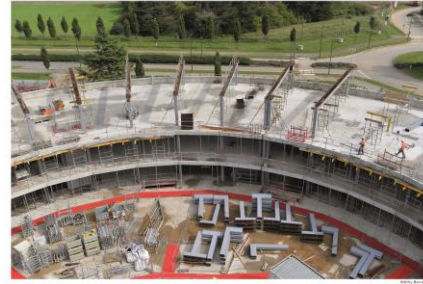
Fig. 2. Picture of the AVRIL construction site
