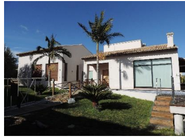
Figura 51. Fotografía de la fachada principal. Fuente propia. 2018
