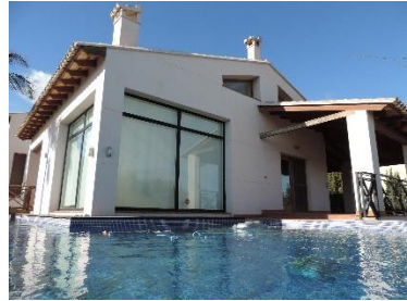
Figura 59. Fotografía de la carpintería exterior. Fuente propia. 2018
