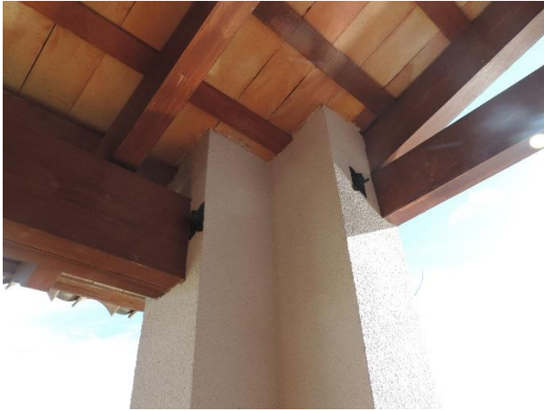
Figura 16: Detalle del encuentro de vigas y pares con pilar exterior. Fuente propia. 2018
