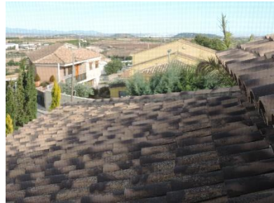
Figura 46. Fotografía de la cubierta. Fuente propia. 2018
