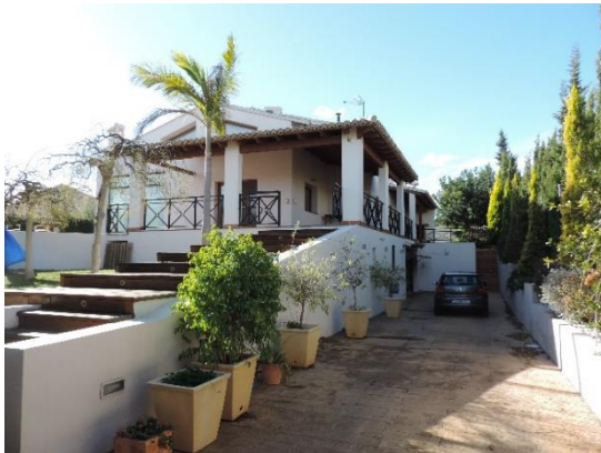
Figura 15: Vista exterior del porche trasero. Fuente propia. 2018
