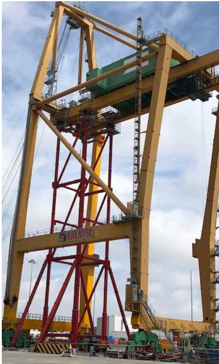
Figura 11: Reparación grúa STS. Fuente: Autor
