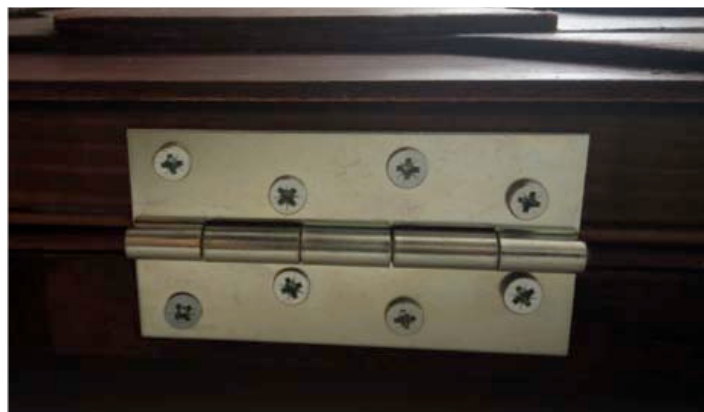
Fig.49 Bisagra atornillada en uno de los laterales de la obra
