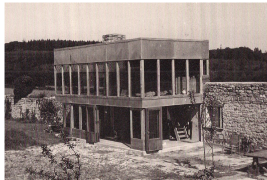
Fig. 25. Vista del pabelló finalitzat des del sud-est en la qual es pot apreciar el sistema de Balloon frame utilitzat.
