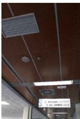
Figura 11. Techo perteneciente a uno de los pasillos de la biblioteca de la UPV.
