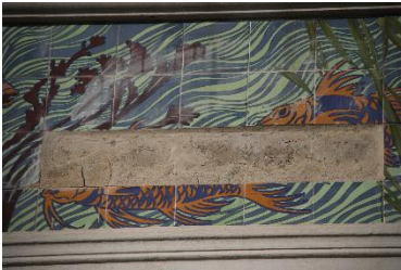
Imagen 20. Laguna del panel cerámico. IMAGEN PROPIA
