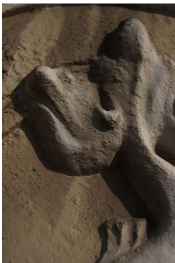
Imagen 18. Polvo y suciedad ambiental acumulada sobre la fachada. IMAGEN PROPIA
