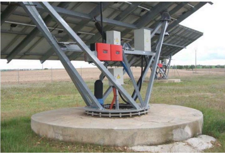
Ilustración 62. Detalles de seguidores solares de doble eje. Fuente: Juan Ángel Saiz (1) / tiendaocanis.com (2)
