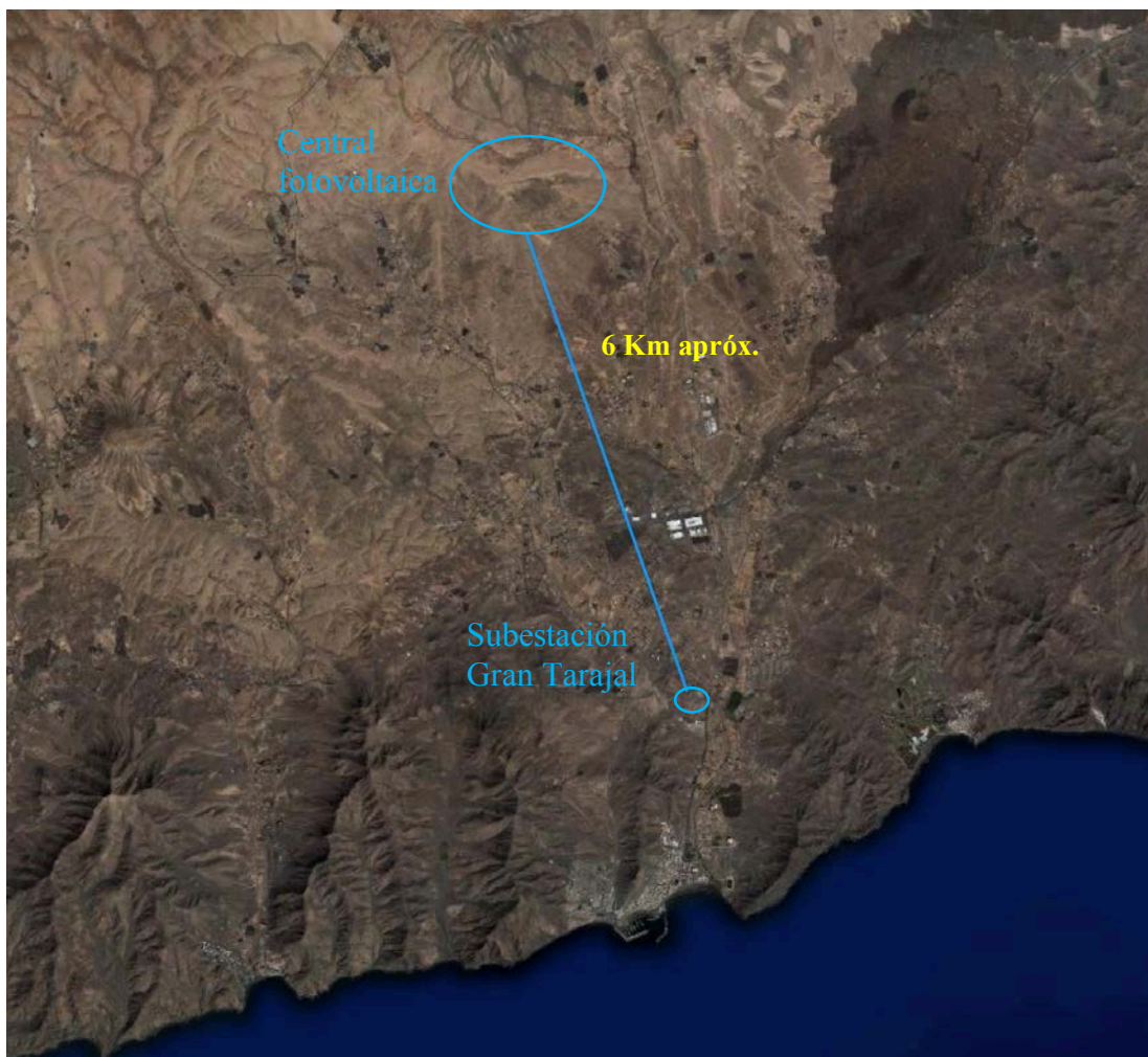
Ilustración 87. Recorrido en línea recta desde la central fotovoltaica hasta la subestación de GT. Fuente:GRAFCAN/Elaboración propia
