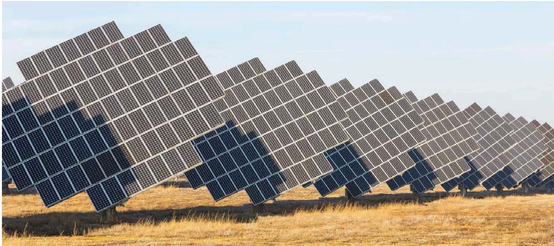
Ilustración 64. Seguidores solares en Cariñena, España. Fuente: Wikipedia Commons.
