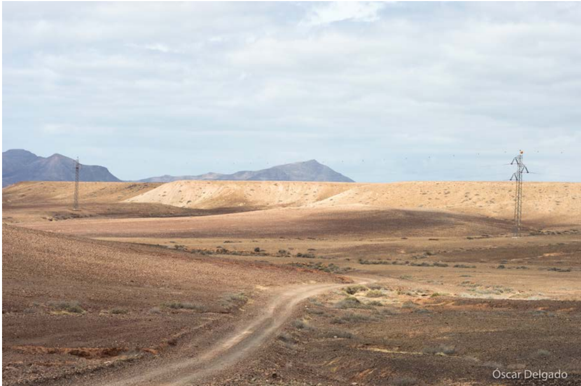
Red de transporte de 66kV, en la zona de Los Arrabales.
