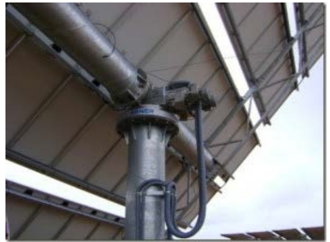
Ilustración 62. Detalles de seguidores solares de doble eje. Fuente: Juan Ángel Saiz (1) / tiendaocanis.com (2)
