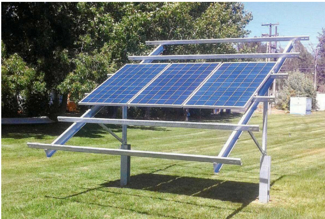
Ilustración 68. Ejemplo de estructura similar a la elegida. Fuente: kitenergy.com
