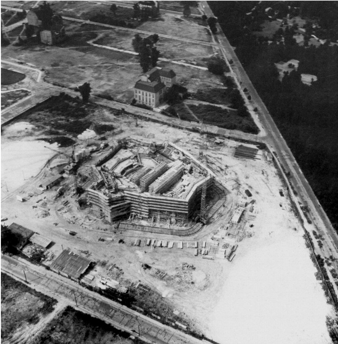
Imagen 03.2.2. Foto aérea desde el sureste durante la construcción. Año 1961-1962
