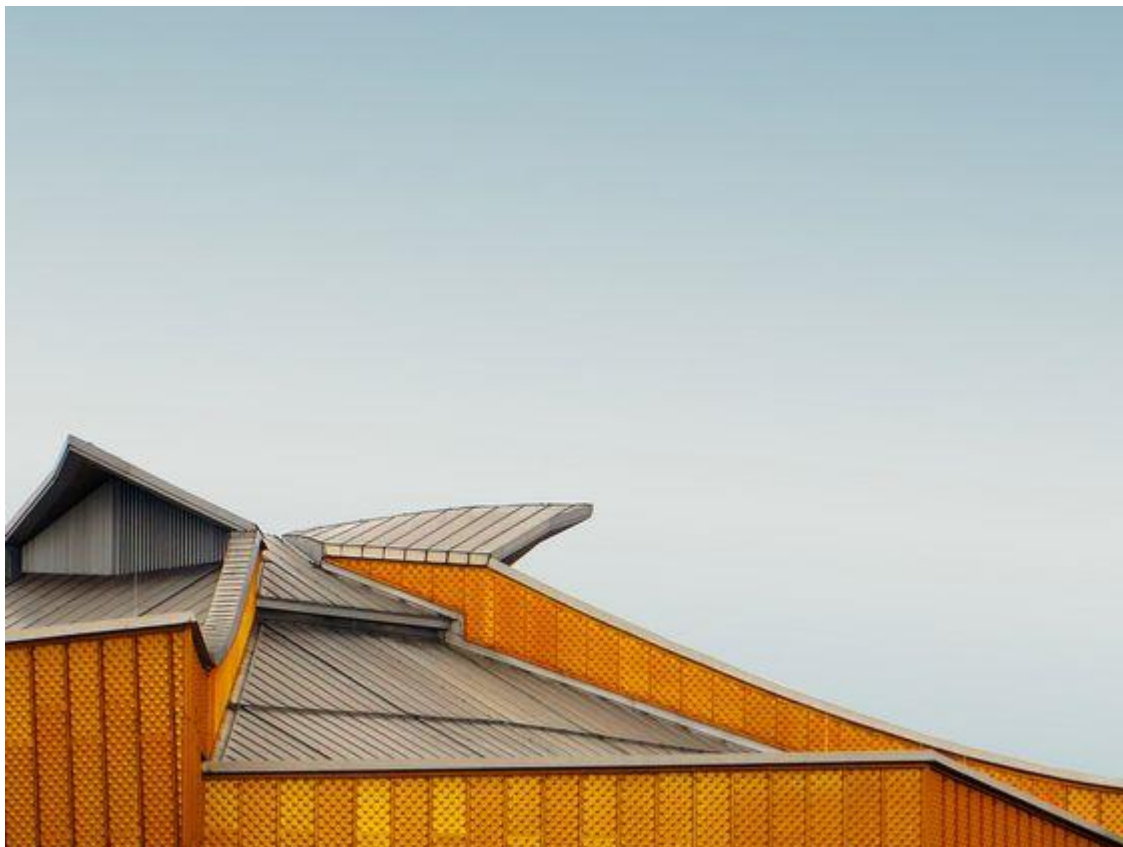
Imagen 10. Contraste de materiales (cerramiento y cubierta)
