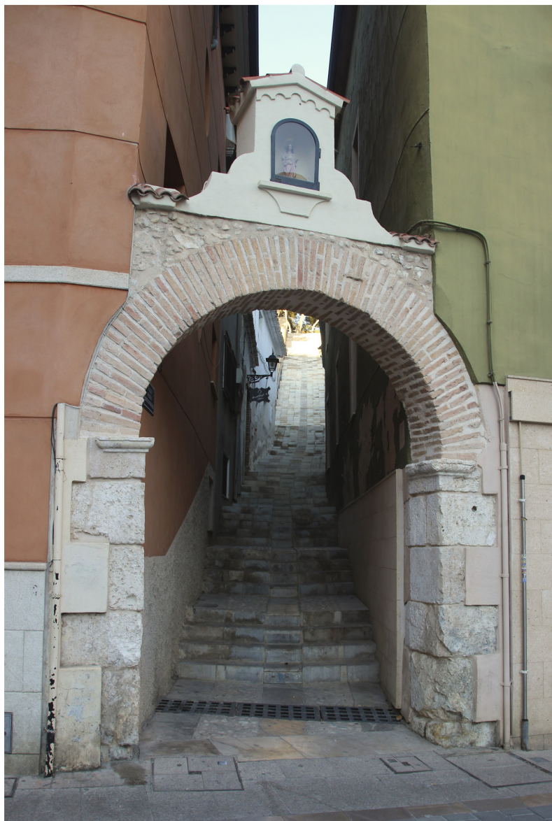
Figura 22. Figura 26. Subida Santa Bárbara en Villena (Alicante). Fuente: Foto del autor.
