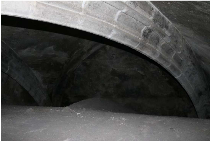
FIG. 17: Nervios de estructura gótica sobre estructura barroca FUENTE: FRANCISCO CASTIBLANQUE LÓPEZ
