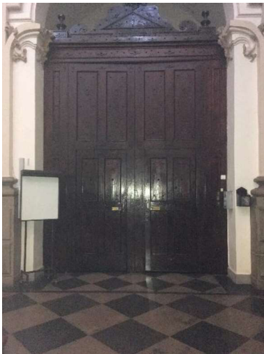
FIG. 95: PUERTA PPAL. FUENTE PROPIA.
