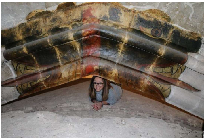
FIG. 18: Espacio apreciable entre estructura barroca y gótica FUENTE: FRANCISCO CASTIBLANQUE LÓPEZ
