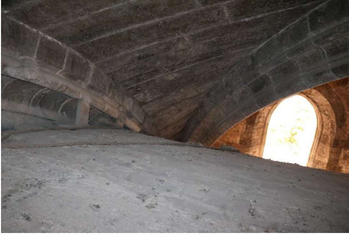
FIG. 19: Nudo nervios estructura gótica FUENTE: FRANCISCO CASTIBLANQUE LÓPEZ
