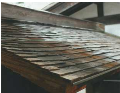
Fig. 57 Detalle del alero de una cubierta de tablillas de madera.
