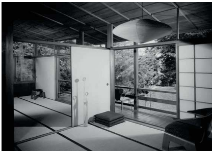
Fig. 16 y 17 Vista interior. La compartimentación interior y el cerramiento se resuelve mediante el uso de los fusuma y shoji .
