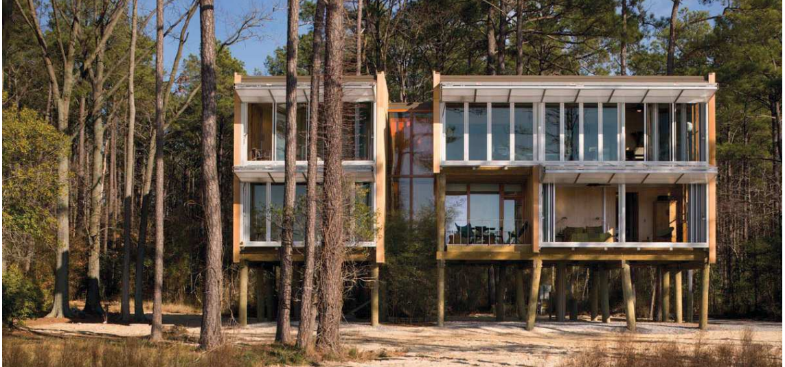
Fig. 41 Vista exterior de la fachada principal.
