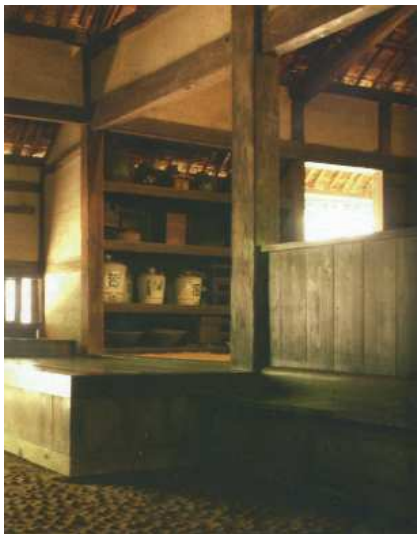
Fig. 7 El daikokubashira consiste en un gran pilar que marca el límite entre la doma y el suelo elevado.
