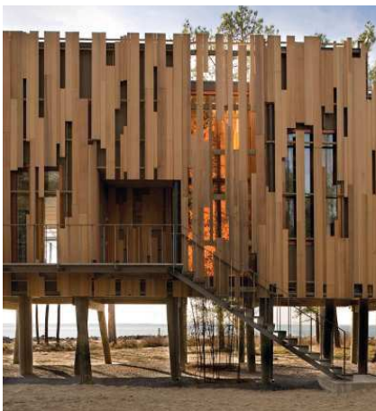
Fig. 43 Vista exterior. Acceso a la vivienda por la fachada trasera.
