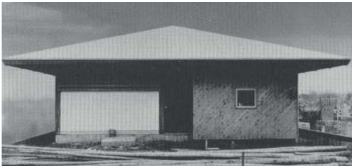
Fig. 25 Vista exterior de la fachada principal.
