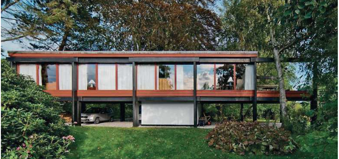
Fig. 20 Vista exterior de la fachada principal.
