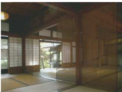
Fig. 51 Yoshizu colgadas de los dinteles a modo de compartimentación interior.
