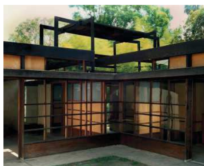
Fig.11 Vista exterior. La carpintería emerge de la estructura de madera. Se emplea una modulación y diseño que recuerda a los koshi japoneses.
