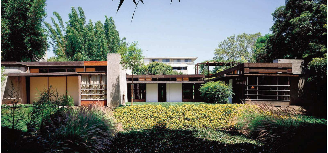
Fig. 7 Vista exterior desde la fachada oeste. Simplicidad formal y predominancia de la horizontal.
