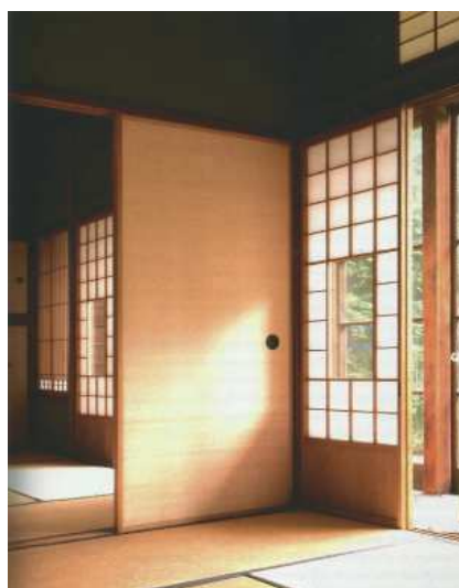
Fig. 54 Akarishoji . Mampara que incorpora una pequeña parte desmontable para dejar entrar la luz.
