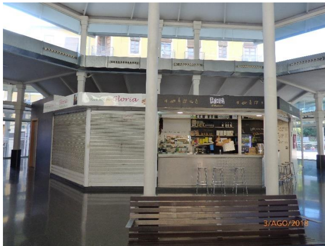
Figura 8: Interior del mercado puestos lado sur. Fuente propia. Año: 2018
