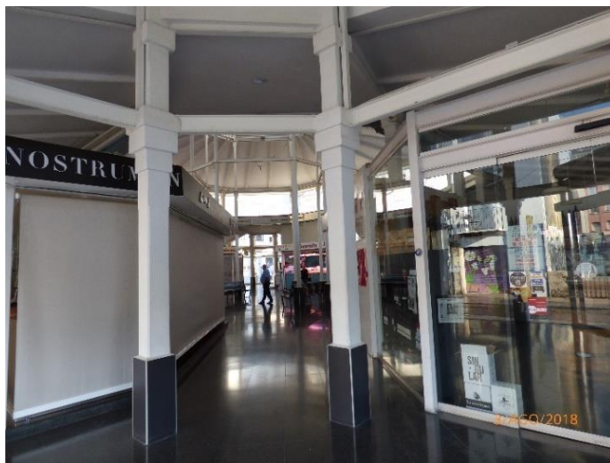
Figura 4: Interior del mercado pérgola sureste. Fuente propia. Año: 2018
