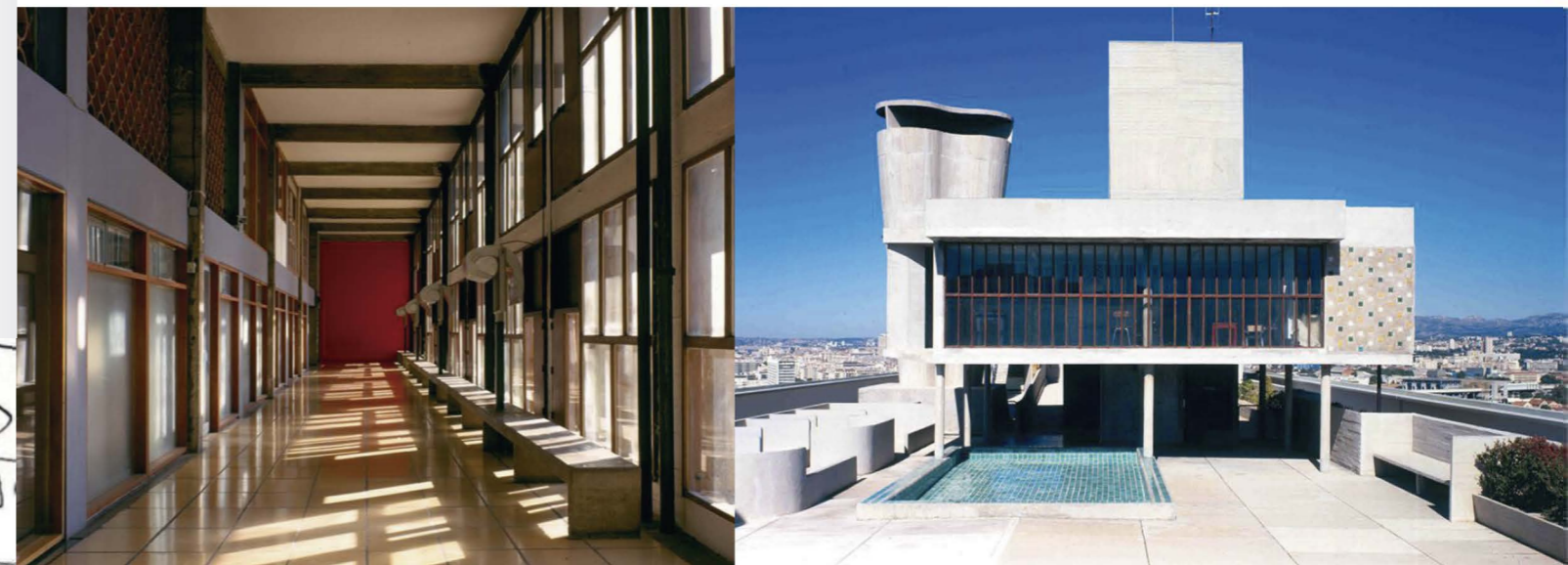
Imagen 19, 20: Pasillo interior, servicios de cubierta en la Unité
