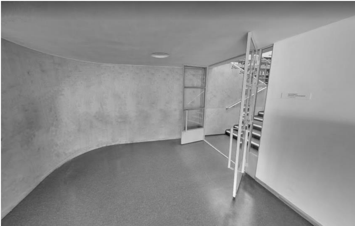
Imagen 31. Vista del muro curvo.
