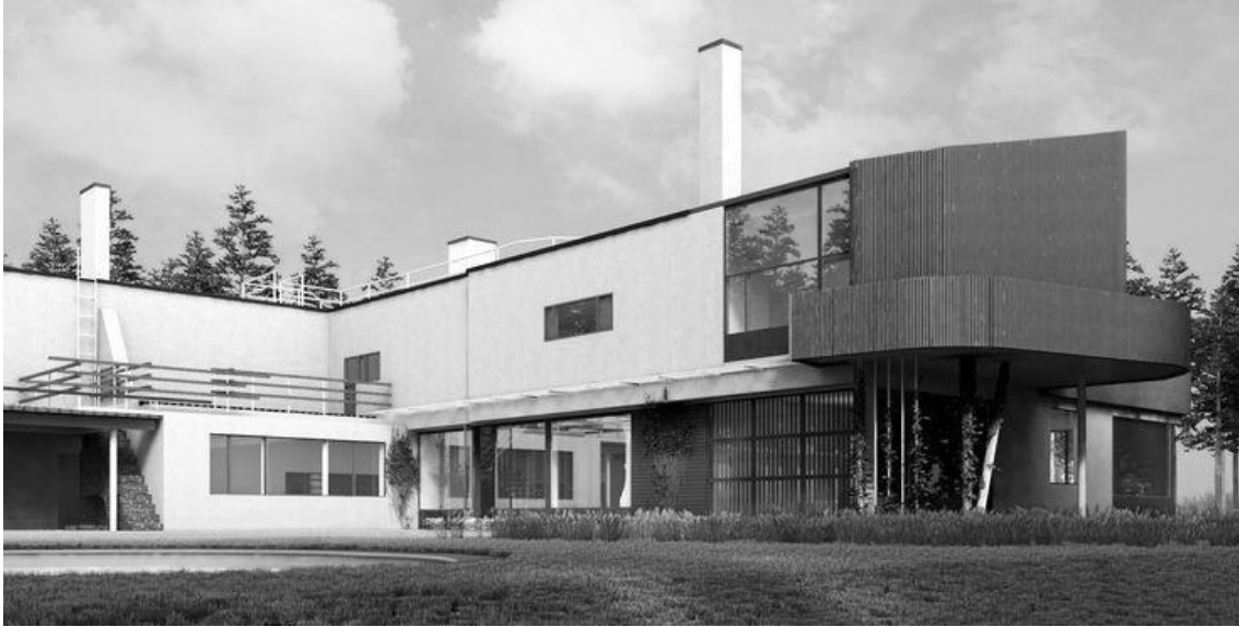
Imagen 58. Vista desde el patio.
