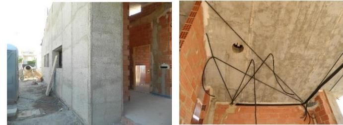
Figura 66. *Enfoscado mortero y paso de instalaciones. Fuente: Elaboración propia.*
