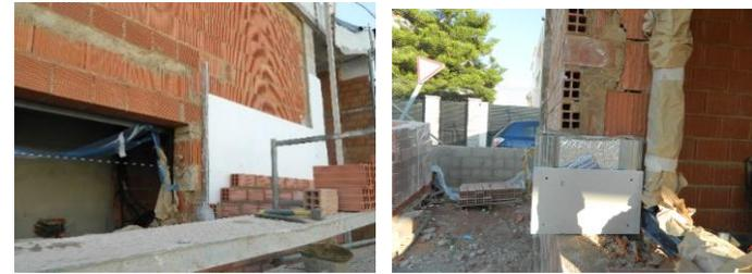
Figura 65. *Proceso constructivo y solución alfeizar. Fuente: Elaboración propia.*
