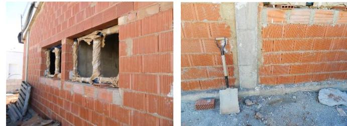
Figura 63. *Premarco ventanas y zócalo. Fuente: Elaboración propia*
