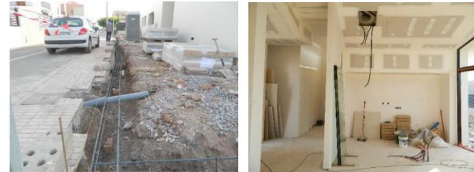
Figura 77. Zuncho perimetral muro exterior y enlucido interior.
