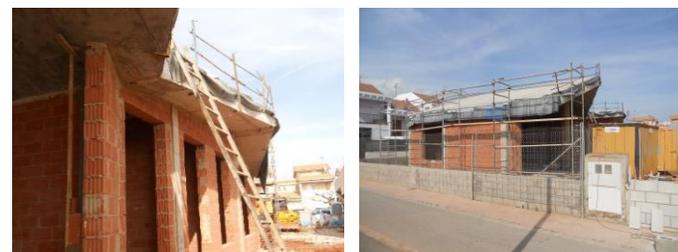
Figura 58. Muro de termoarcilla. Fuente: Elaboración propia.
