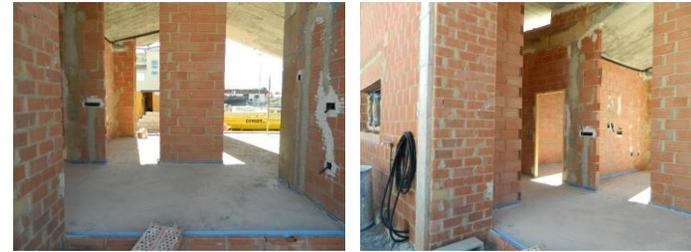
Figura 62. *Capa de mortero sobre suelo radiante. Fuente: Elaboración propia*
