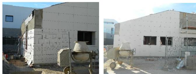
Figura 68. Colocación revestimiento exterior. Fuente: *Elaboración propia*
