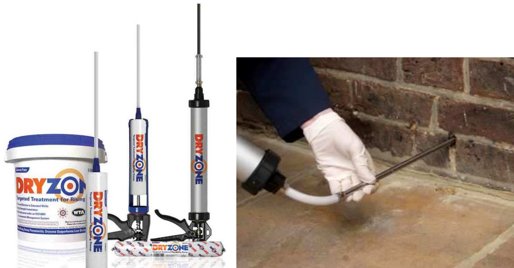
FIGURA 75: Material de DRYZONE y su puesta. (HUMICONTROL)
