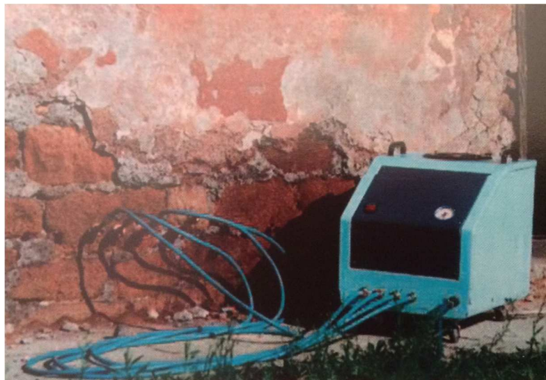
FIGURA 74: Proceso de inyección con bomba. (F. Vegas y C. Mileto. 2014)
