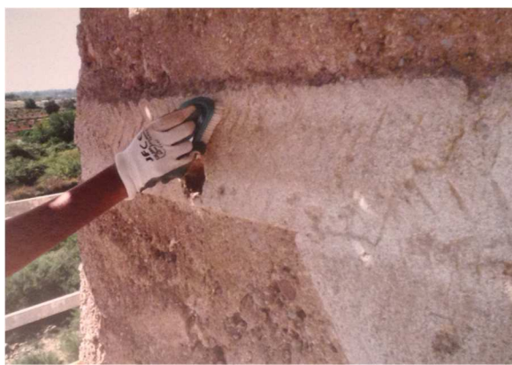
FIGURA 60: Cepillado manual. (F. Vegas y C. Mileto. 2014)
