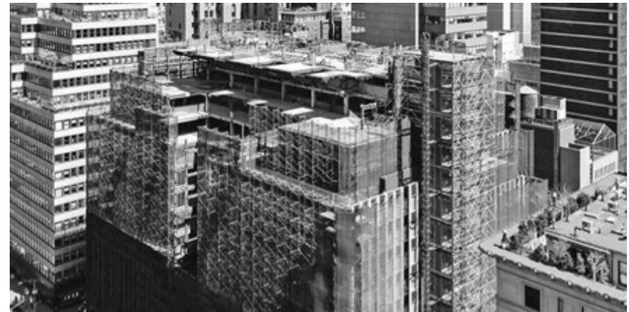
Img 69. 425 Park Avenue Tower en construcción.
