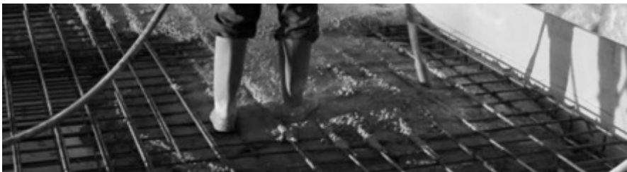
Img 126. 3-Vertido de hormigón.
