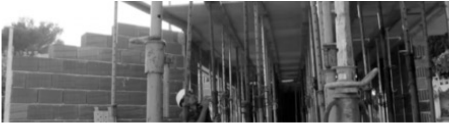
Img 124. 1-Encofrado de la losa.
