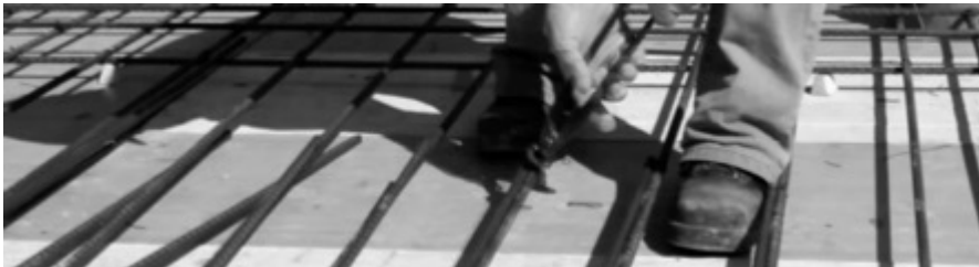
Img 125. 2-Colocación de Armaduras.
