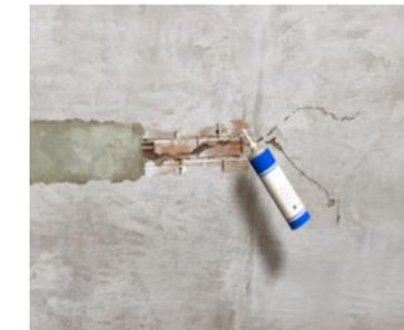
3. A continuación, se realizará la aplicación del mortero Planitop HDM MAXI de Mapei, el cual es un mortero bicomponente fibrorreforzado indicado para la reparación y el refuerzo de elementos de ladrillo.
