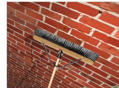
3. Se limpiará y se colocará un mortero drenante microporoso Draining de la casa Humicontrol, este tipo de mortero acelera el proceso de secado y evita que las sales minerales acumuladas durante años sigan manteniendo la humedad e incluso que la absorban del propio ambiente.
