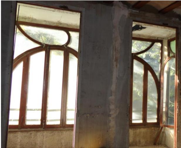
*Figura 57. Carpintería exterior mirador. 2018. Fuente: Propia*
