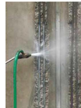
Limpeza de las armaduras con chorro de agua y arena
