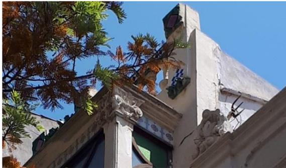
*Figura 64. Gárgolas para evacuación de aguas pluviales. 2018. Fuente: Propia*
