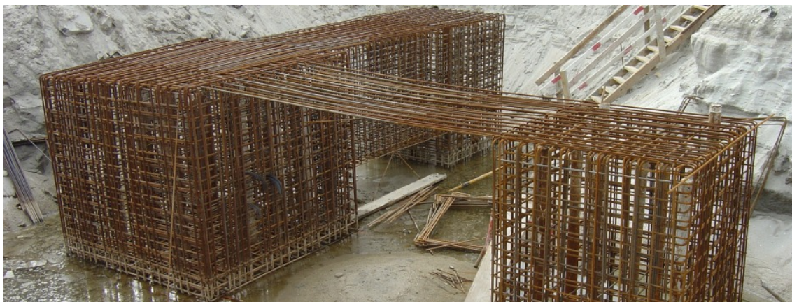
Figura 341 Ejecución de los cimientos. Gabinete de Organización y Proyectos.
