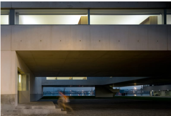
Figura 21l Biblioteca de Viana do Castelo, Álvaro Siza. Vista desde Acceso.
