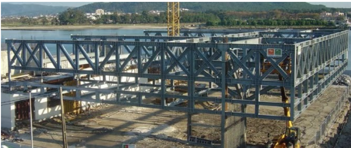
Figura 28I Ejecución de la estructura. Gabinete de Organización y Proyectos.
