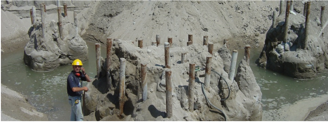
Figura 331 Ejecución de los micropilotes. Gabinete de Organización y Proyectos.
